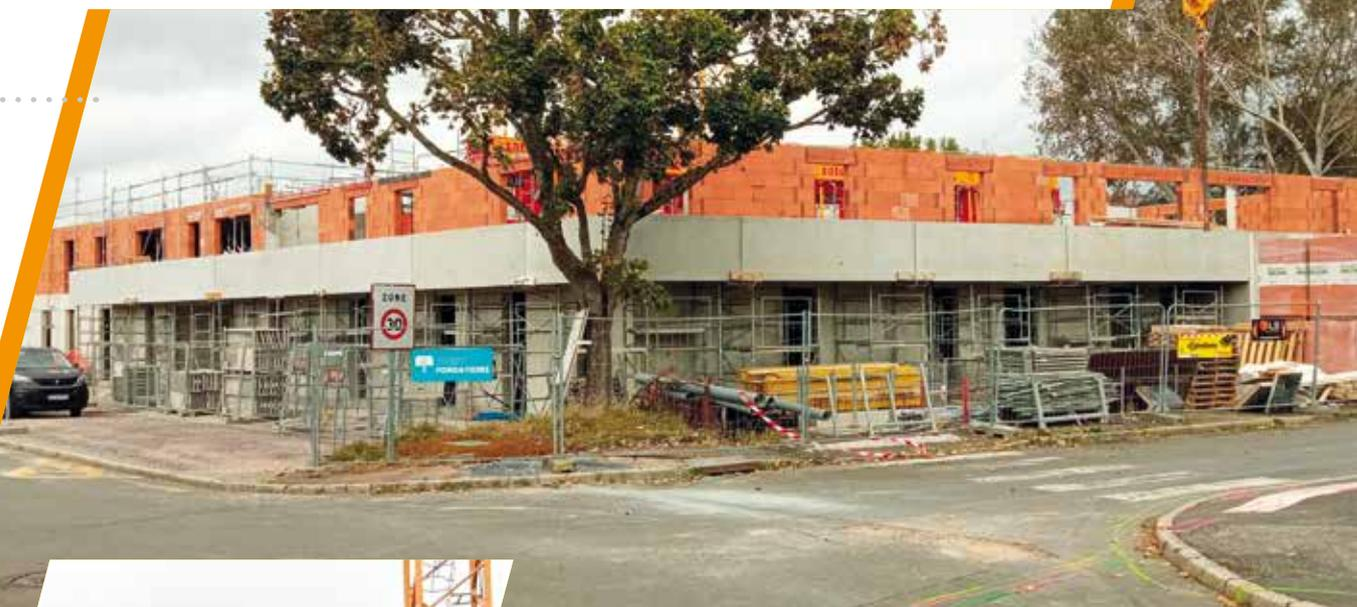
**Les travaux de gros œuvre ont bien avancé :** début novembre, l'élévation du 2<sup>ème</sup> étage est en cours. La prochaine étape sera la pose de la charpente et des menuiseries extérieures.
